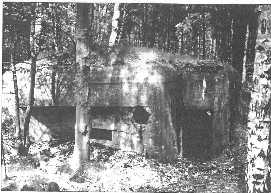
Piąty - ostatni schron bojowy linii obrony w Jastarni.
