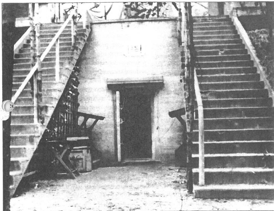
Wejście na stanowisko ogniowe.
